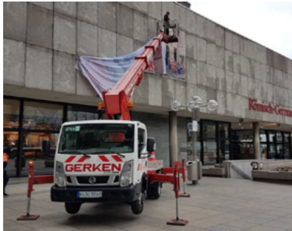
◀ Unterstützung der Angie Hiesl Produktion: Als Kölner Kulturpate stellen wir eine unserer Arbeitsbühnen für das Anbringen und Abhängen der Fotobanner an der Fassade des Römisch-Germanischen Museums zur Verfügung
