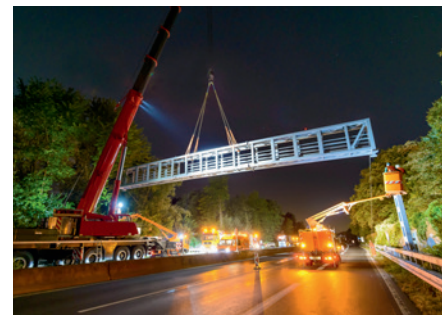
▲ Vollsperrung der A 40 in Bochum. Gerken ist mit 5 Mitarbeitern die ganze Nacht vor Ort, um die Absperrmaßnahmen ggf. an geänderte Anforderungen anpassen zu können.
